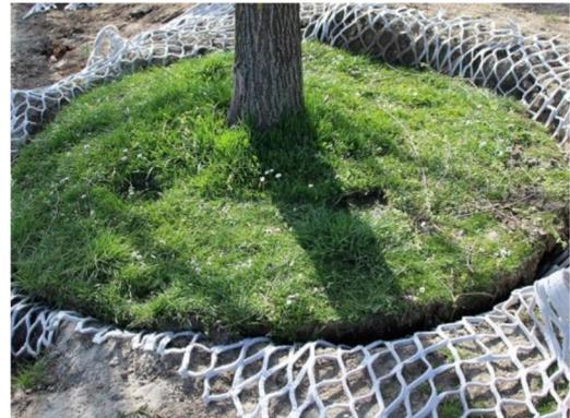
Das Bewässerungsvlies wird als Netz geliefert, welches vor der Pflanzung auseinandergezogen um den Wurzelballen der Bäume gelegt wird. Danach kann es ganz einfach mit Erde überschüttet werden und entfaltet seine hervorragenden Wasserspeicher-Fähigkeiten. Die Wasserspeicher-Netze nehmen Gieß- und Regenwasser in großen Mengen auf und geben es langsam an die umliegenden Wurzeln wieder ab, dabei wird gleichzeitig Staunässe verhindert.
